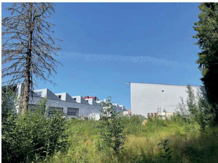
Alue 2: puustoa on poistettu kun maastoa on muokattu ja Saksanrimpen on johdettu hulevesiputki kuten kuvasta näkyy.
